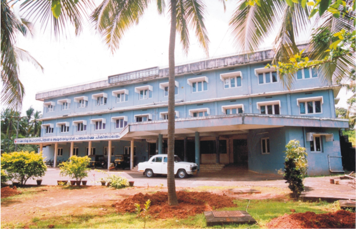
केन्द्रीय वक्फ परिषद से प्राप्त ऋण सहायता से निर्मित जामिया अरबिया कसरगोड (केरल) अस्पताल भवन
